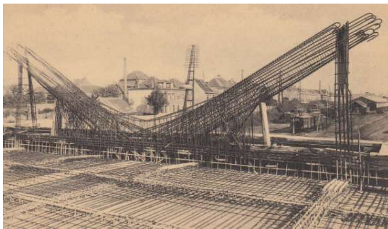
Prentbriefkaart van de staaldraadbekabeling voor de bouw van een brug type "Bow-String" te Moeskroen, niet gelopen.
